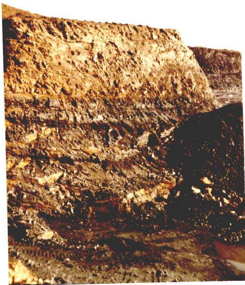
FOTO 22' TALUD 227 OBSERVACIONES: NOTESE LA ACUMULACION DE DETRITOS.
