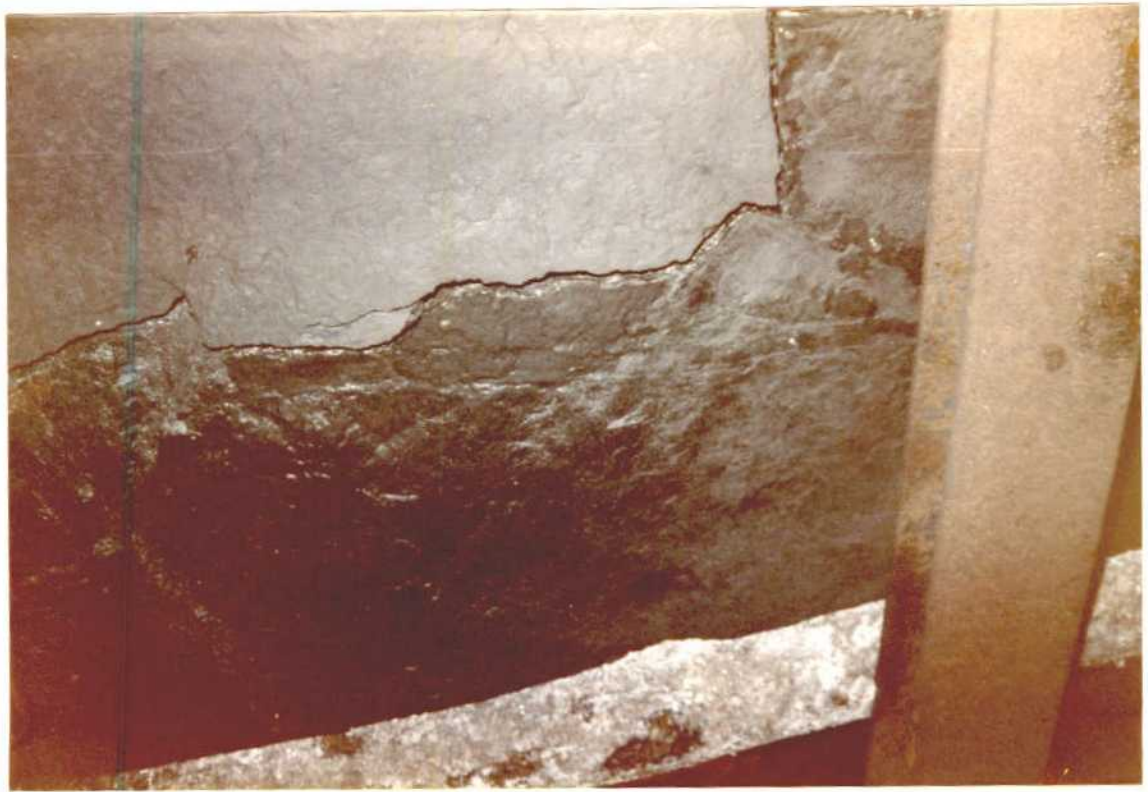
FISURACION DEL TECHO
