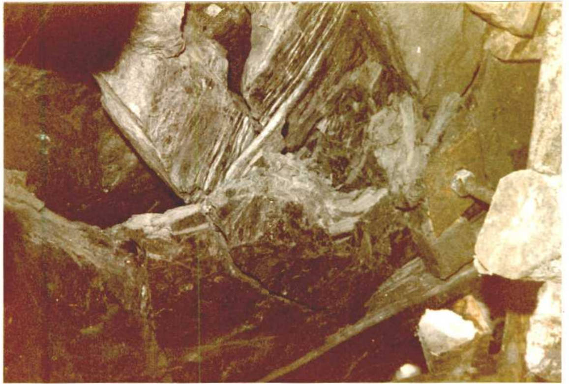
ASPECTO QUE PRESENTA EL TECHO DE LA GALERIA.
