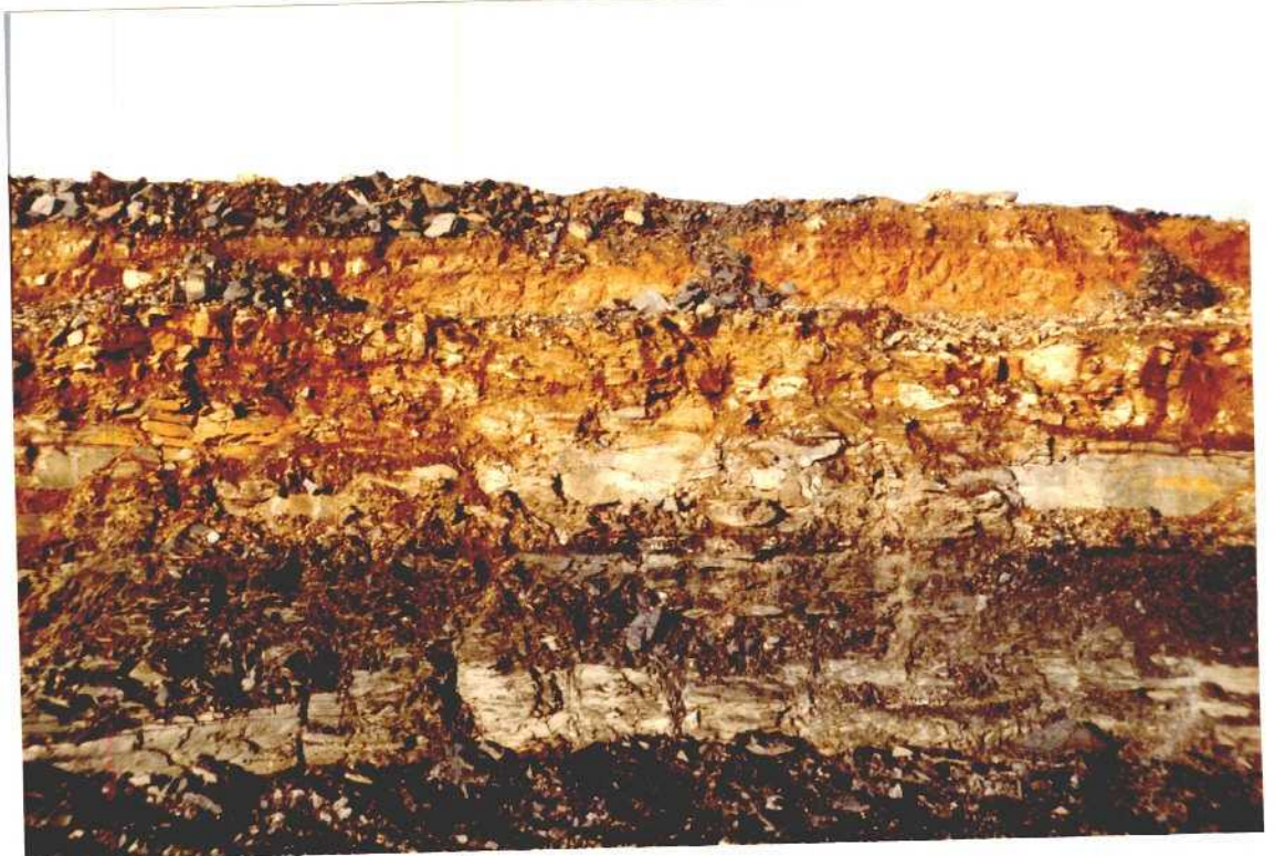
FOTO 9. TALUD 205. OBSERVACIONES: NOTESE EL GRAN DIACLASADO DEL TALUD.
