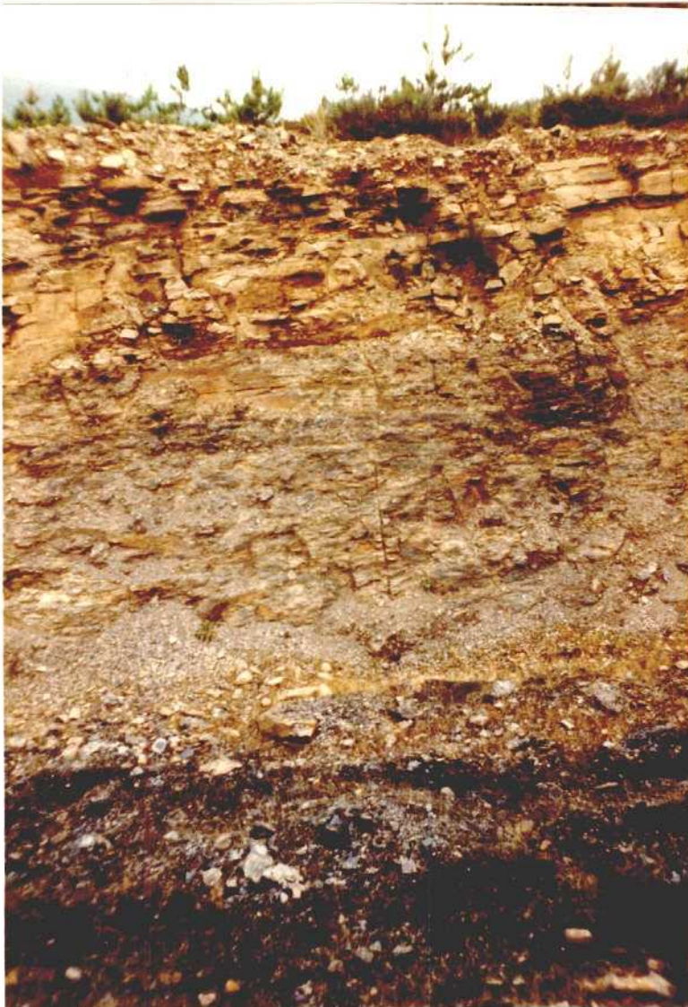
FOTO 13. TALUD 210. OBSERVACIONES: NOTESE LA ALTERACION Y DIACLASADO DE LA PARTE ALTA.
