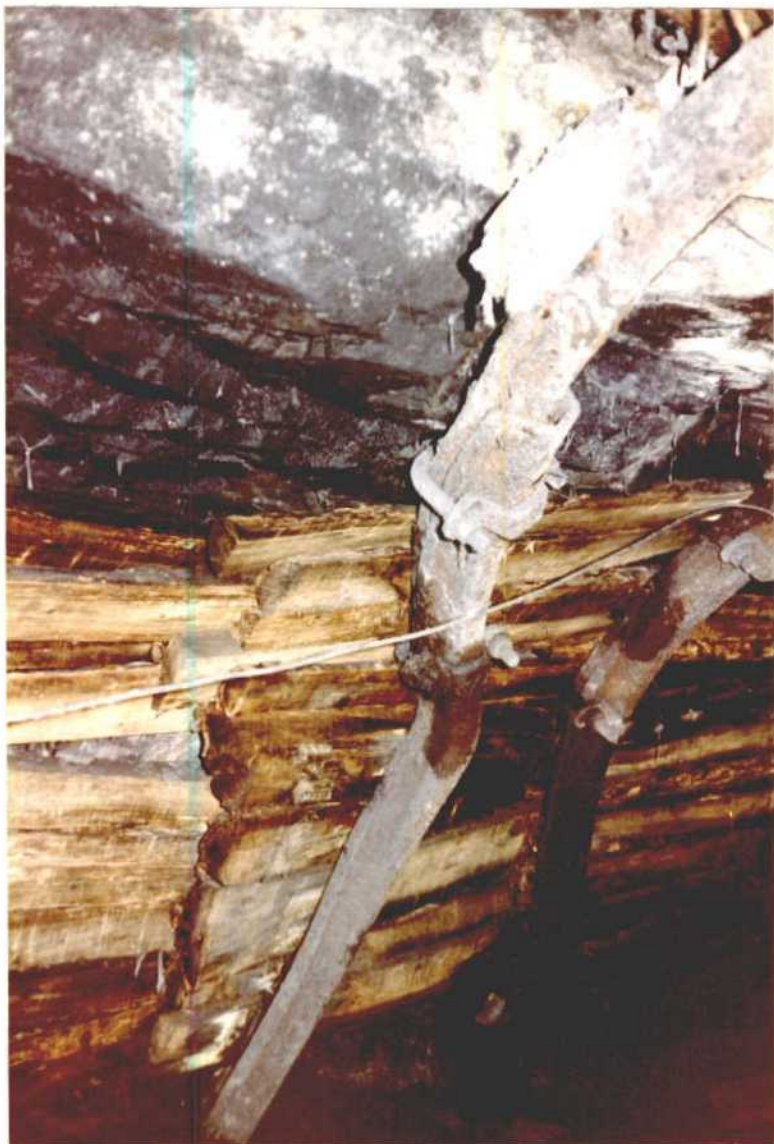
ASPECTO DEL REVESTIMIENTO DE MADERA COLOCADO.
