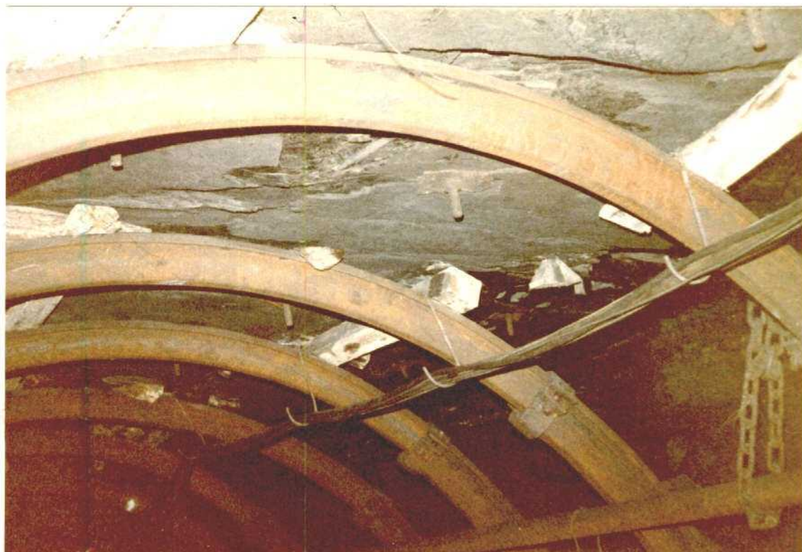
ENTIBACION MEDIANTE CUADRO TH-29 Y BULONAJE .
