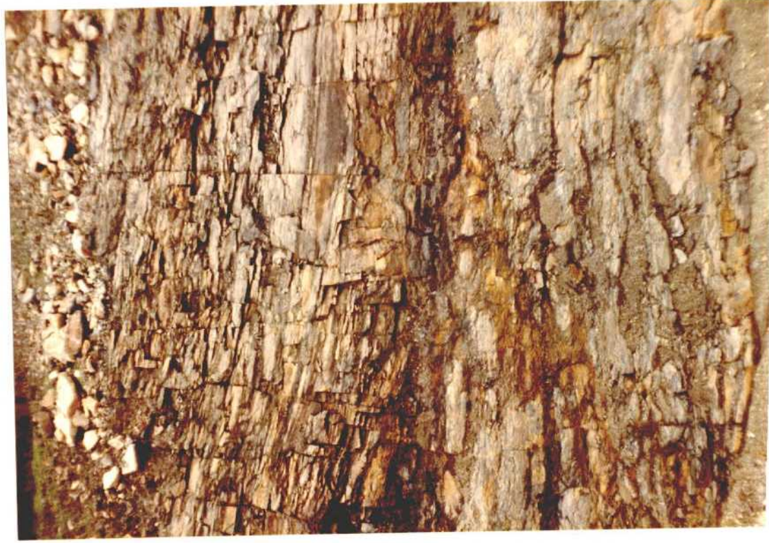
FOTO 18. TALUD 214 OBSERVACIONES: NOTESE LAS DIACLASAS RECTAS PARALELAS Y CERRADAS.
