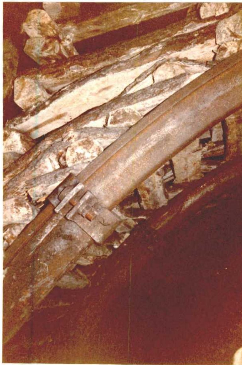
CASTILLETE REALIZADO HASTA ALCANZAR EL TECHO DE LA GALERIA.
