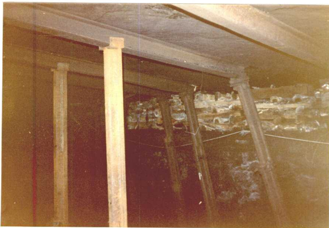
ASPECTO PARCIAL DE LA ENTIBACION.
