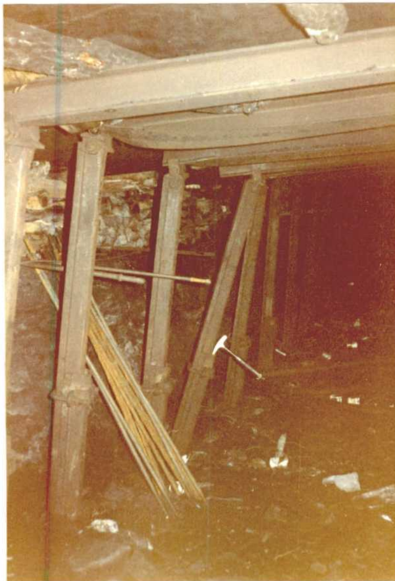
FISURACION DEL TECHO
