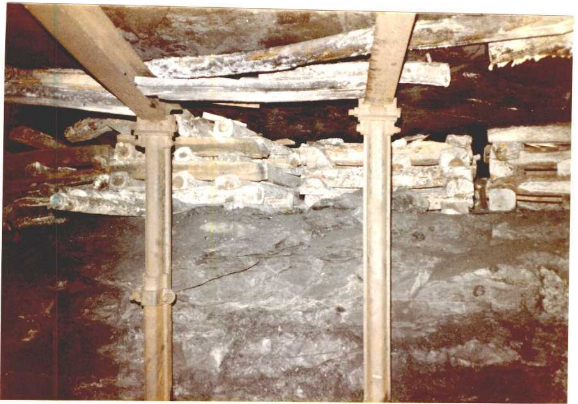
ASPECTO PARCIAL DE LA GALERIA.
