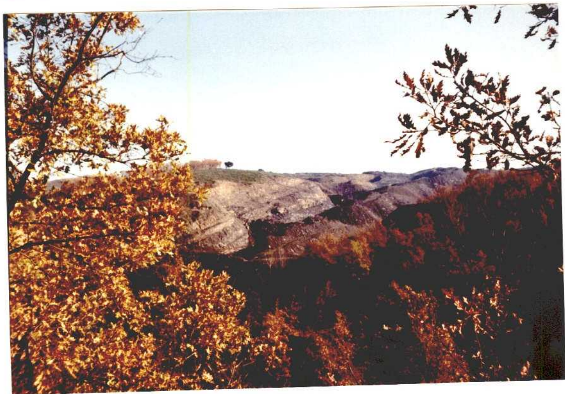
FOTO 23', TALUD 228. OBSERVACIONES: NOTESE LOS DERRUBIOS ACUMULADOS AL PIE.
